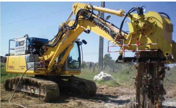
Afin de sécuriser son réseau au lendemain de la tempête de 1999, RTE (Réseau de Transport d'Électricité) a lancé une campagne de vérification et de renforcement de ses pylônes. La technique proposée consiste à mettre en œuvre des massifs de renforcement au niveau des semelles de fondations. Ceux-ci sont réalisés en mélange sol-ciment à l'aide d'un outil Trenchmix monté sur une pelle.
