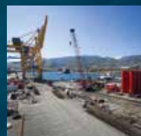
MISE À NIVEAU DE QUAIS approfondissement, élargissement
