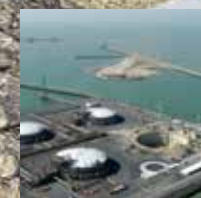
FONDACTIONS des plateformes de stockage, des bâtiments et des cuves
