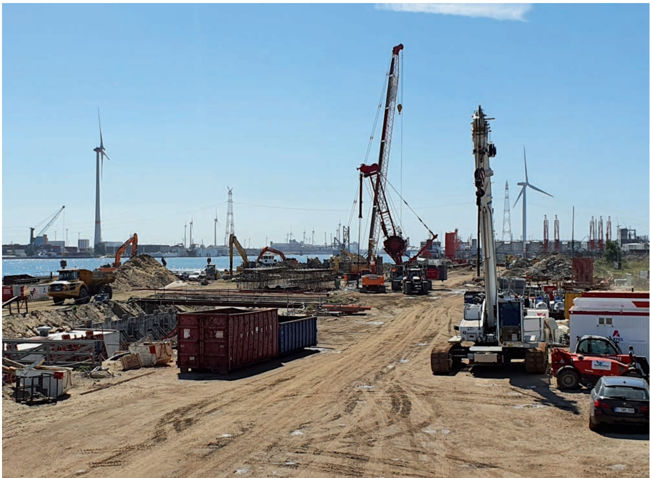
Vue globale sur le chantier
