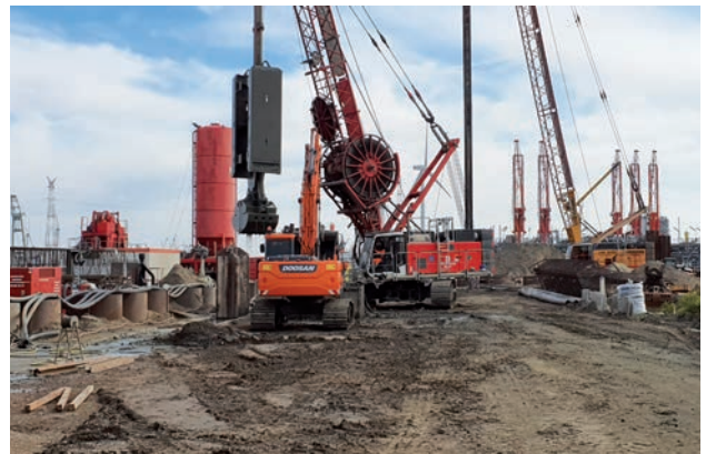
Creusement des parois moulées sur le Kanaaldok B2
