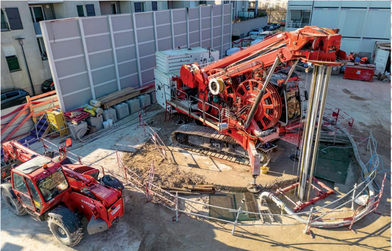
Après divers aménagements réalisés fin d'année dernière pour viabiliser le terrain, les équipes du chantier, menées par Soletanche Bachy France, ont pu achever les travaux de prétraitement avant les vacances de Noël. Ces travaux de prétraitement, comprenant 30 forages à 46 m de profondeur, ont nécessité l'injection de 50 m<sup>3</sup> de coulis bentonite-ciment dans le sol pour éviter d'éventuelles pertes de boue lors de l'exécution de la paroi moulée.
