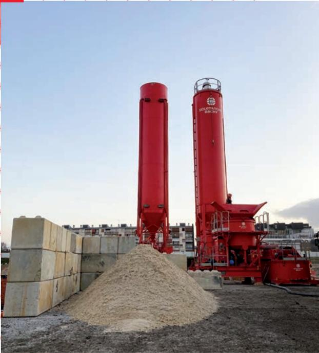
Les travaux prévoient la réalisation de 200 forages à 49 m de profondeur et la mise en place de 1 400 m<sup>3</sup> de comblement et 420 m<sup>3</sup> de traitement.
