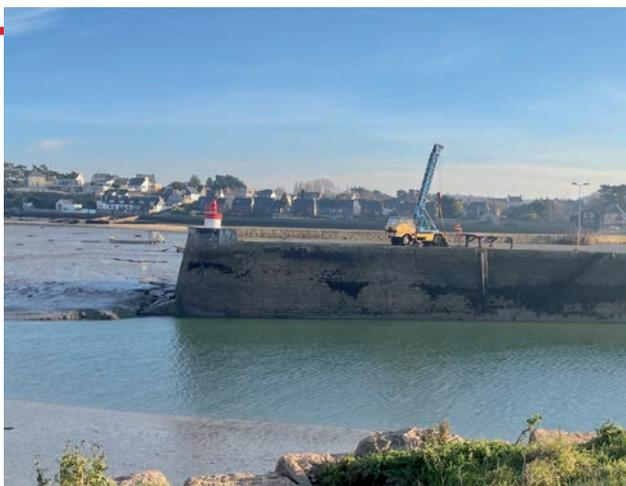
Le musoir en remblais, d'une dizaine de mètres de hauteur, partiellement submersible, souffre de plusieurs pathologies : drainage insuffisant, phénomène de renard hydraulique au niveau des terrains d'assise, érosion des remblais, dégradation de l'état général des parements maçonnés.
