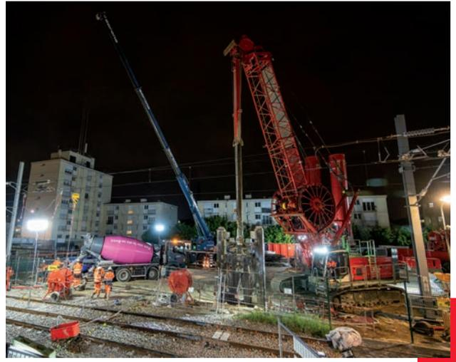
Les 16 panneaux de PAC, d'épaisseur 500 mm et d'une dizaine de mètres de profondeur, ont été réalisés en un peu plus d'une semaine avec un panneau réalisé de nuit. L'atelier d'excavation a ensuite enchaîné avec les travaux de paroi moulée de même épaisseur, mais allant jusqu'à 13 m de profondeur pour certains.
