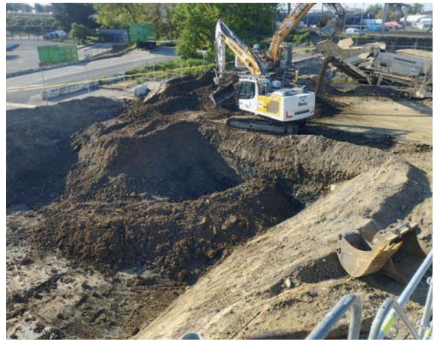
Dépollution / tri amiante
