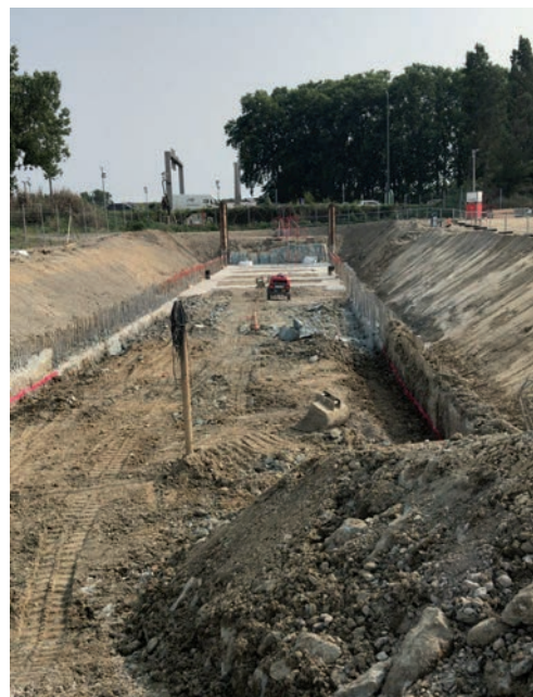
Pré Terrassement et recépage des parois moulées.
