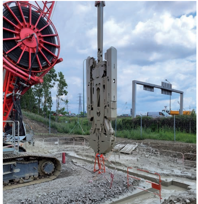
Réalisation des parois moulées
