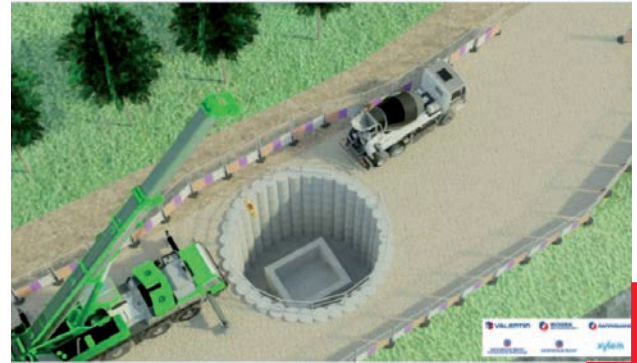
Réalisation du génie civil du regard
