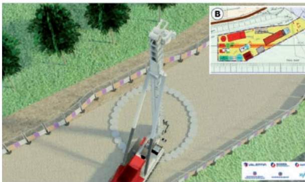
Réalisation bouchan étanche (Installation de la centrale d'injection au droit du regard R6)
