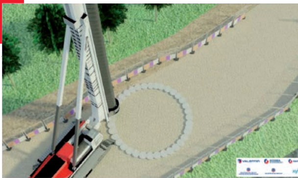
Réalisation des pieux sécants
