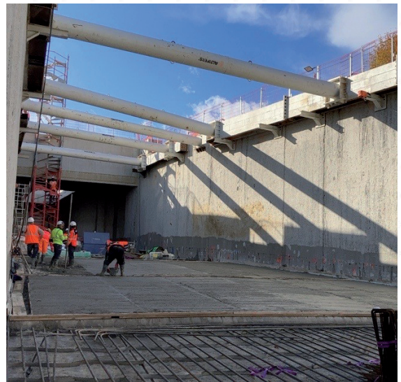
Puits de sortie
