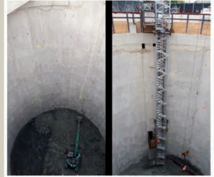
Vue de la paroi moulée Grand Paris Express - T2A - puits circulaire 1501P
