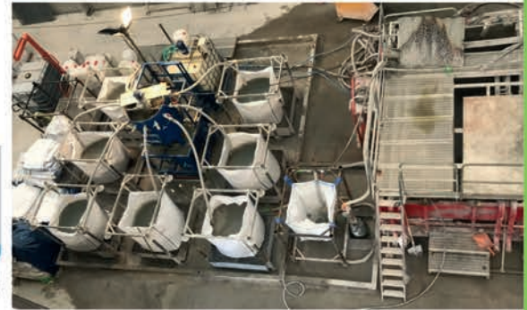
Installation sur le chantier du TELT
