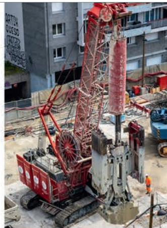
Bâchage du KS
