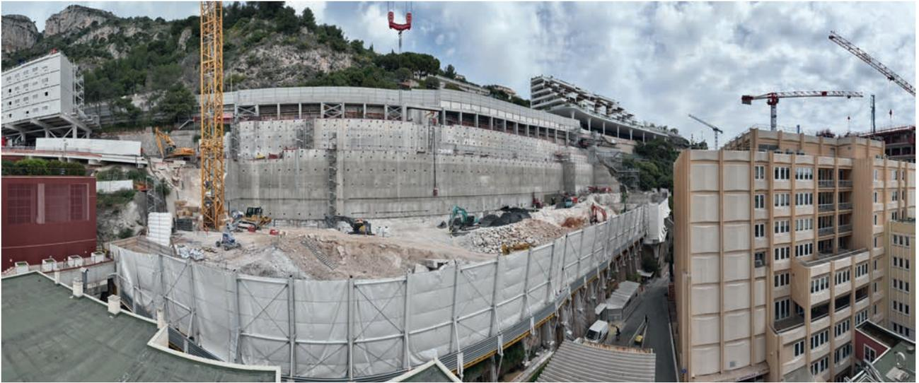
embase d'une dizaine de mètres, en créant une paroi de soutènement verticale jusqu'à 32 m de haut.
