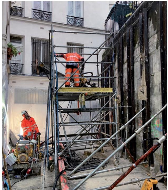
Ce mur subit en effet, depuis quelques années, des déformations importantes, et il présente de grosses fissures. Il est en effet construit sur une ancienne carrière à ciel ouvert qui a été remblayée.
