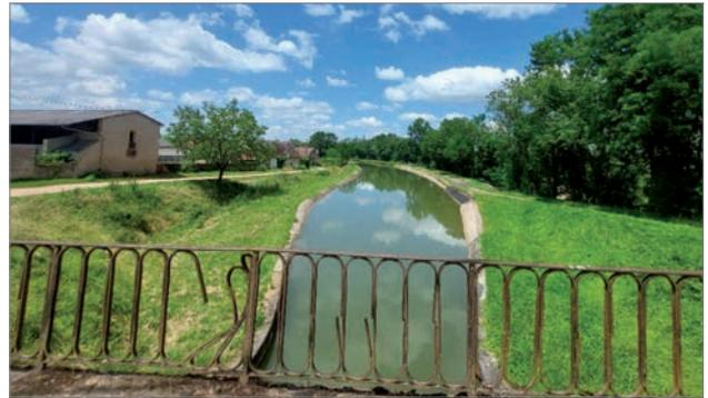
Des fuites ont été constatées dans un canal latéral à la Loire, à travers la digue en rive droite, avec un mécanisme d'érosion interne. En parallèle, des désordres ont été constatés sur le cuvelage du canal.
