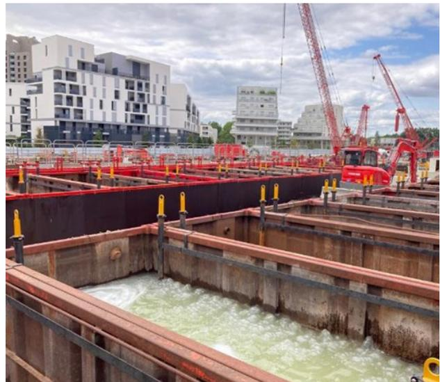
Centrale polymère : cuves équipées d'émulseurs d'air
