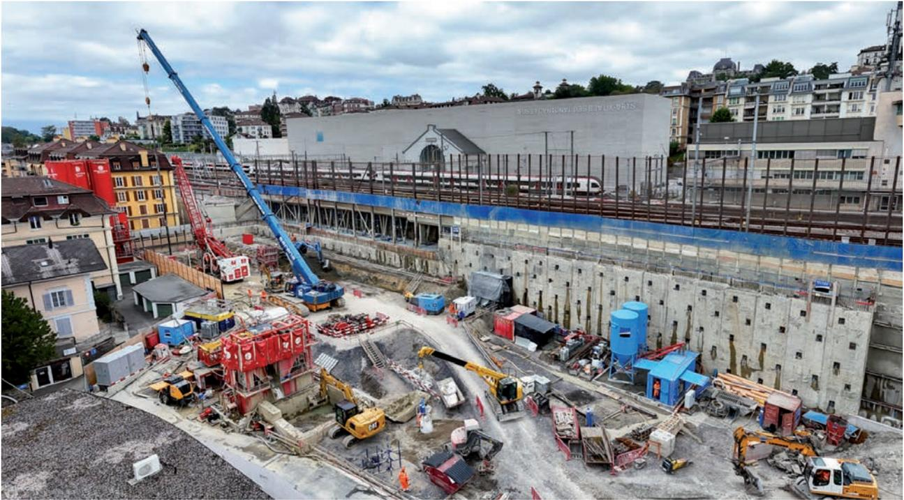
Le chantier a démarré en juillet 2023 avec l'installation des équipements, suivie par le début des activités d'excavation en septembre 2023. Les travaux se sont déroulés dans un espace particulièrement restreint, limité à des plates-formes de 12 m de large à proximité immédiate des voies ferrées en service.
