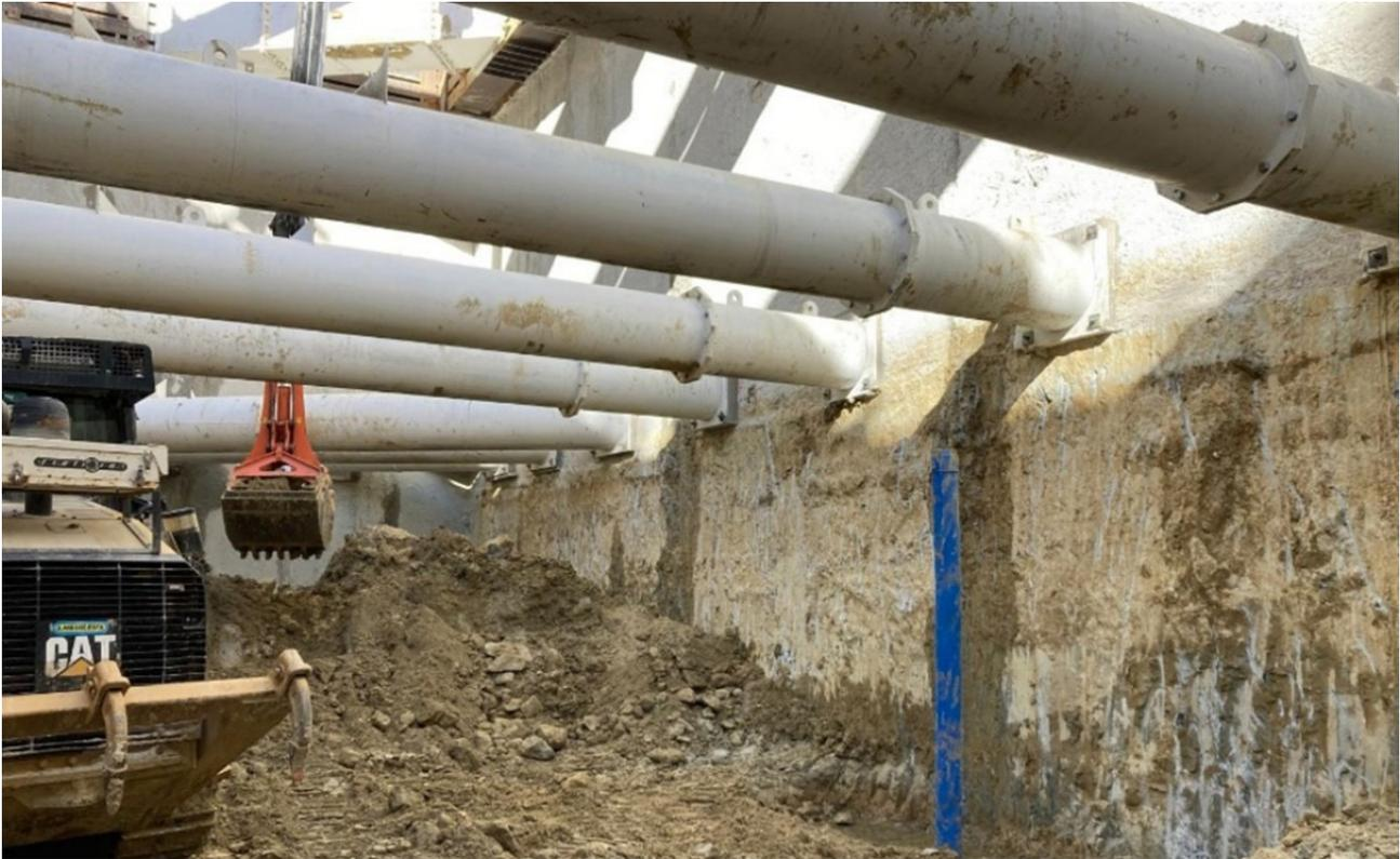
Découverte de la paroi moulée réalisée sous fluide de forage au polymère
