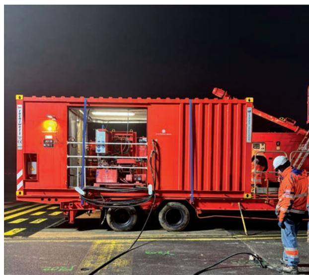
Des forages sont réalisés à environ 8 m de profondeur avec un équipement en tubes en manchettes, afin de mener un comblement gravitaire via l'espace annulaire, puis une injection sous pression par passes remontantes avec le tube à manchettes. Les moyens matériels sont adaptés aux contraintes logistiques de ce chantier : des ateliers mobiles pour le forage et pour l'injection permettant leur amenée et leur repli chaque nuit d'intervention.
