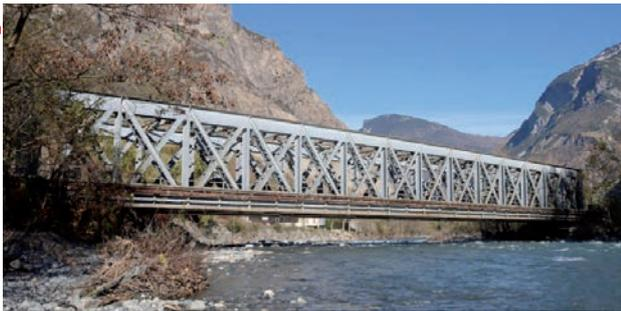
Afin d'asseoir la nouvelle charpente métallique, des extensions aux culées maçonnées existantes, accolées à ces dernières, sont nécessaires : il est ainsi prévu 4 poteaux (5 m de hauteur, 2,5 m par 5 m de section).
