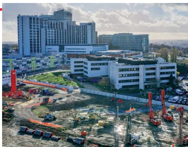
Après les parois moulées réalisées cet été, une nouvelle phase vient de démarrer avec les micropieux et les pieux sécants.
