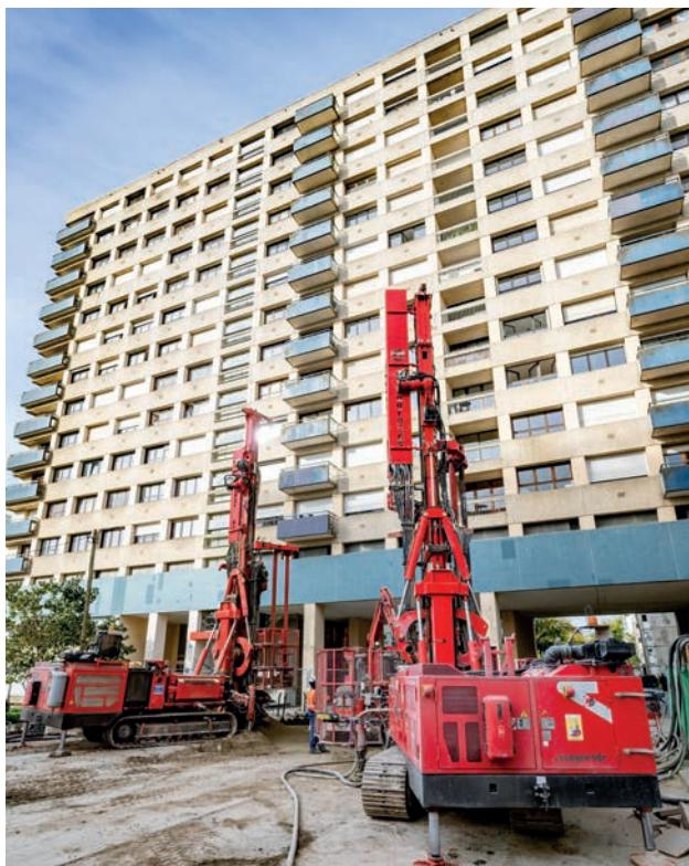
À ce jour, la production au niveau de l'avenue Guyenne est terminée et laisse place aux phases de terrassement, de récépage et de réalisation des dalles de couverture.
