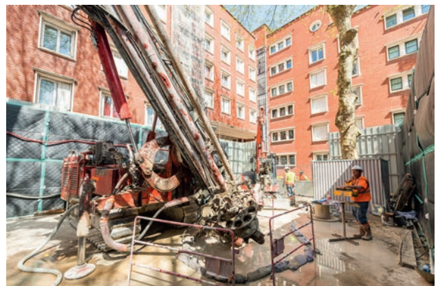
Gare du Vert de Maisons (Grand Paris) : forages pour injection et congélation
