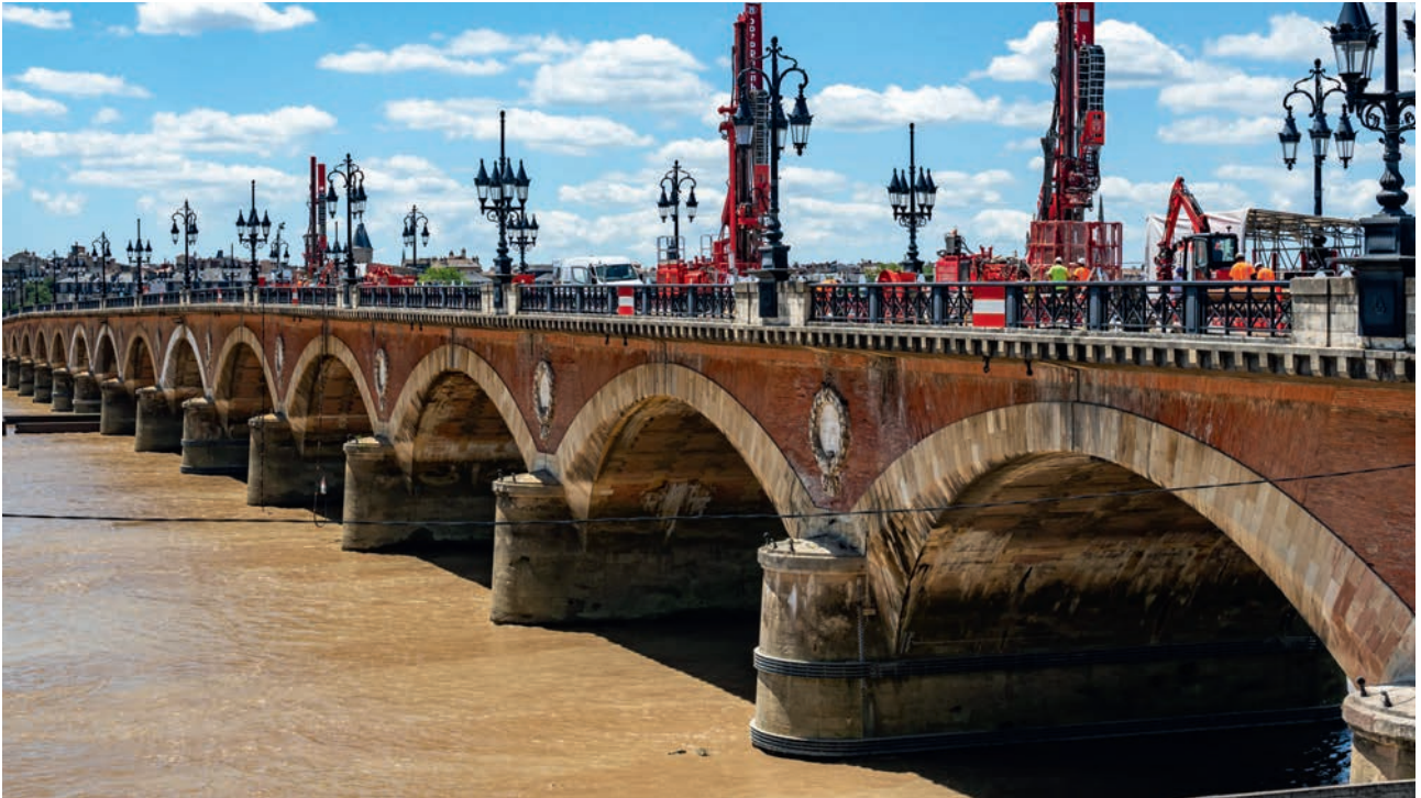
Bordeaux - Pont de Pierre : micropieux
