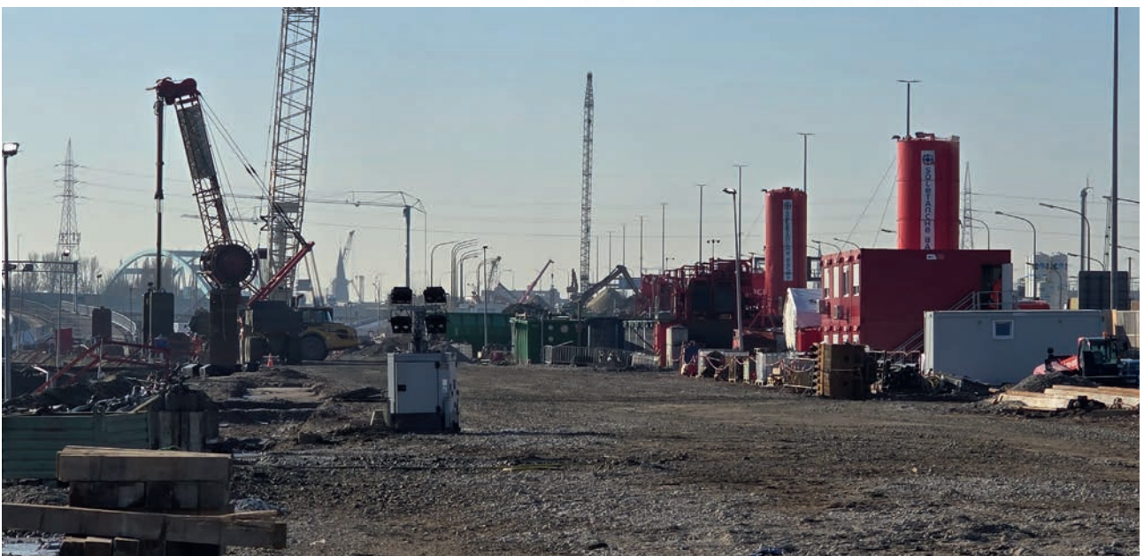
Vue sur les installations de chantier
